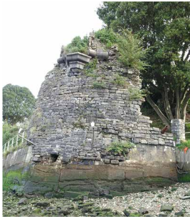
Angle du mur de la batterie basse.
